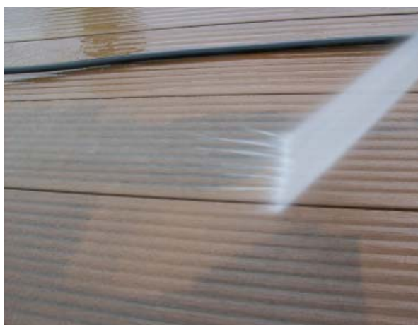
Detail čištění terasy.
